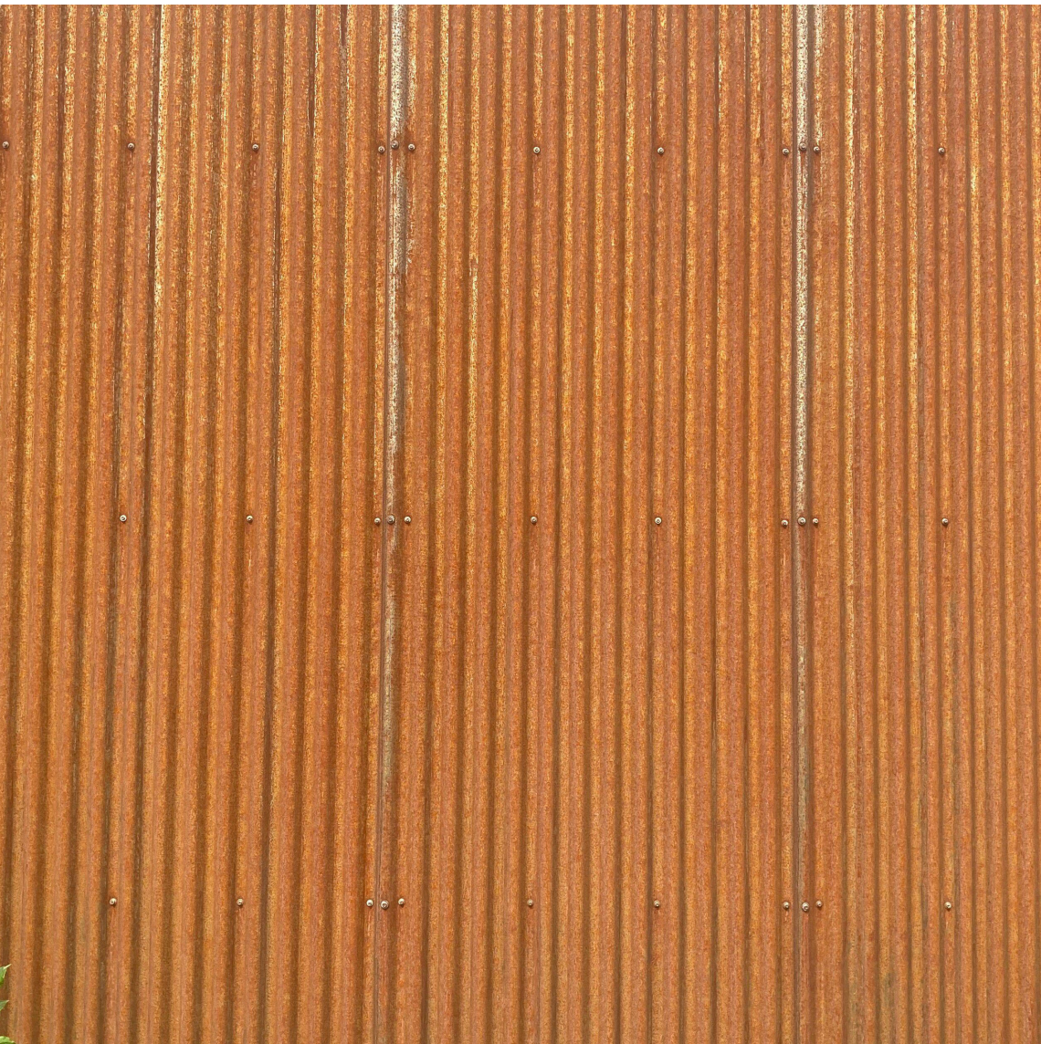
CORTEN SIDING MATERIAL.
