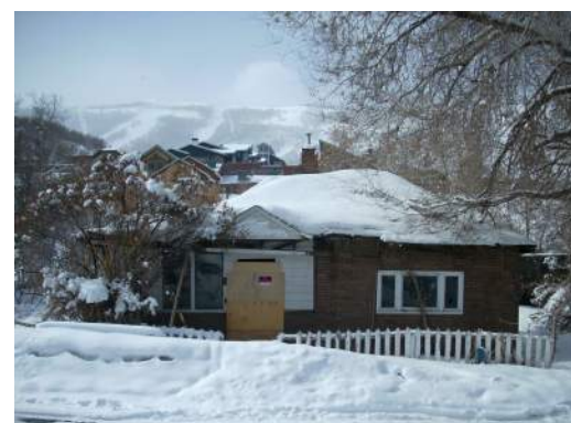
1 Existing Looking West SCALE: N.T.S.
