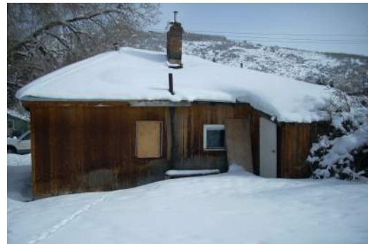
3 Existing Looking East SCALE: N.T.S.
