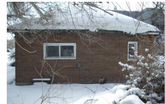
4 Existing Looking South SCALE: N.T.S.
