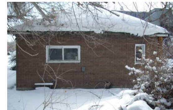
4 Existing Looking South SCALE: N.T.S.
