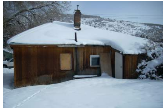
3 Existing Looking East SCALE: N.T.S.
