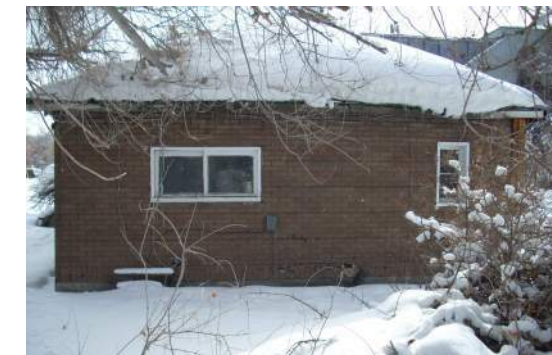
4 Existing Looking South SCALE: N.T.S.
